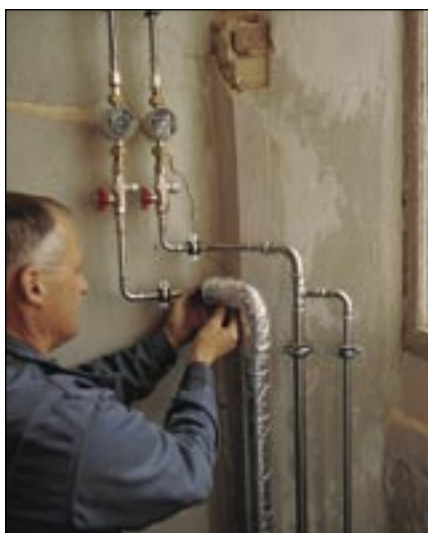
2. užmauname ant izoliuojamos alkūnės
